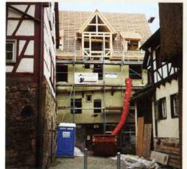
Der neue Dachstuhl muss neu gedeckt werden, zum Teil mit alten Biberschwanz-Ziegeln.
